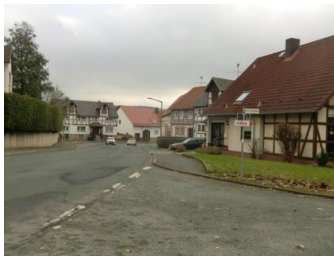
Die Warburger Straße in Niederelsungen wird zukünftig neu ausgebaut. In diesem Zuge kommt es auch zu einer Erneuerung des Gehweges, die eine Gehwegabsenkung im Einmündungsbereich der Dorfstraße beinhalten wird.
