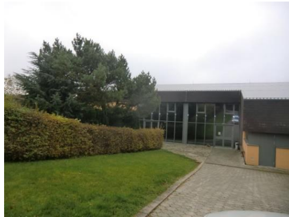
Unterer Bereich des Grünstreifens ist zu steil.
