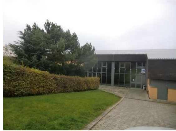
Unterer Bereich des Grünstreifens ist zu steil.
