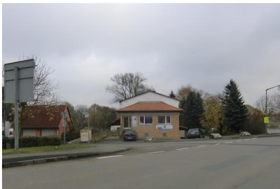
An der Einmündung „Nothfelder Straße“ und „Steinweg“ fehlt eine Bordsteinabsenkung.
