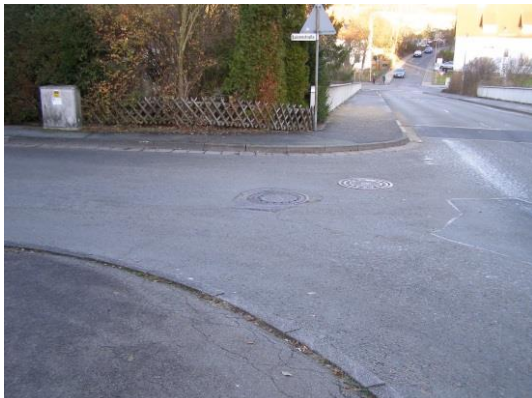
Karlstraße: Einmündungsbereich „Luisenstraße“
