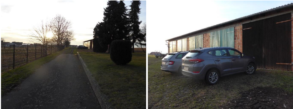
Abb. 3-2: Blick vom Sonnenweg / am Ortsrand Zum Grundstück mit Scheune
