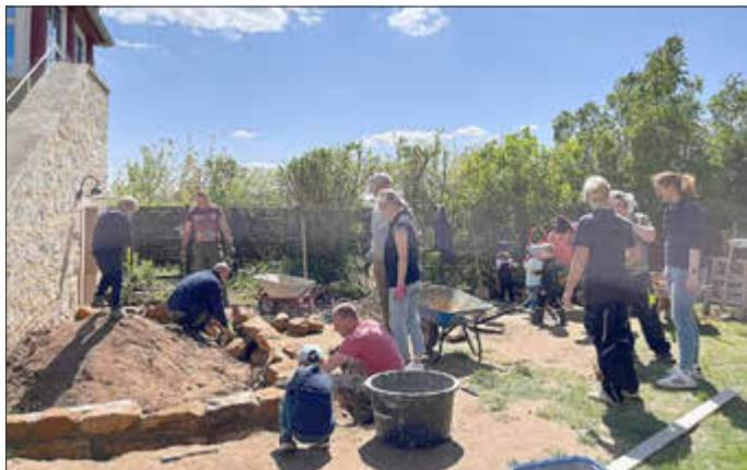
Fleißige Helfer beim Legen der Sandsteinmauer für den Naschgarten
