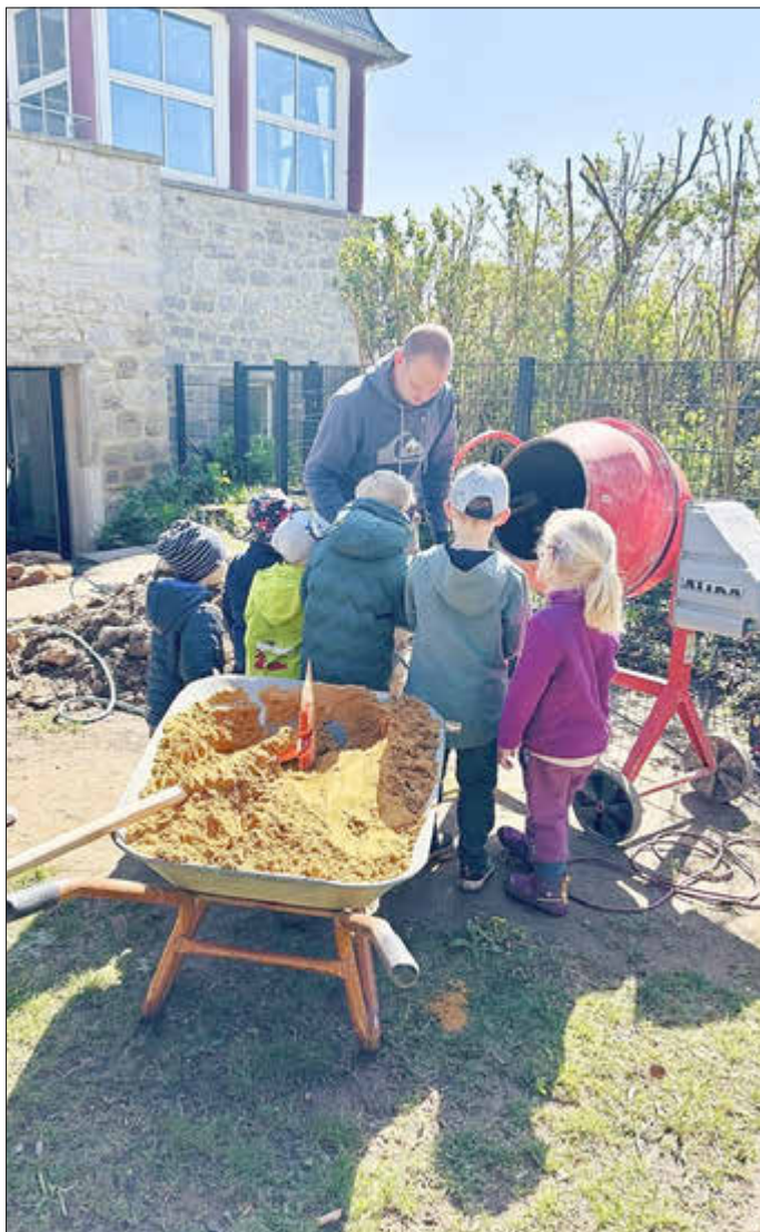
Die Kinder mischen selbst Mörtel an
