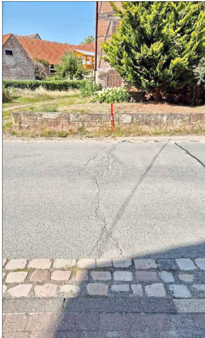
So sind beispielsweise im Bereich der Bärenbergstraße 21 Fahrbahnbeschädigungen durch Risse mit Fahrbahnabsenkungen entstanden, die zu erhöhter Lärmbelastung für die Anwohner sowie zu Gefahren durch durchfahrende Fahrzeuge führen. Darüber hinaus wurde von Anwohnern auf weitere Schädstellen entlang der Bärenbergstraße hingewiesen, die durch das hohe Verkehrsaufkommen zusätzlich belastet werden.
