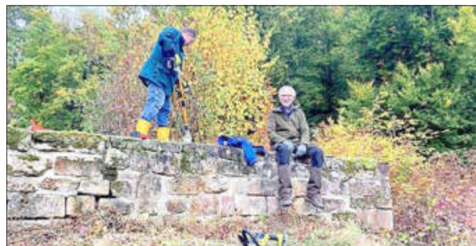
So verwachsen wurde der Burgberg am Freitag vor Arbeitsbeginn angetroffen.
