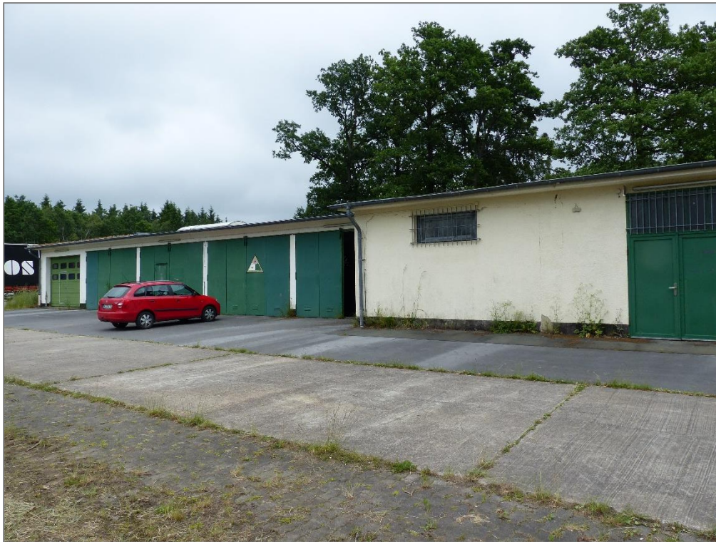
Abbildung 19: Verkaufsobjekt F: Gebäude 45
