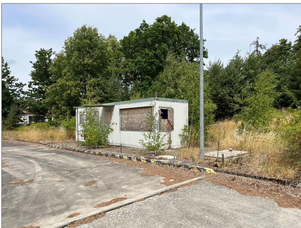
Abbildung 24: Verkaufsobjekt I, Gebäude 35B (ehemalige Panzertankstelle)
