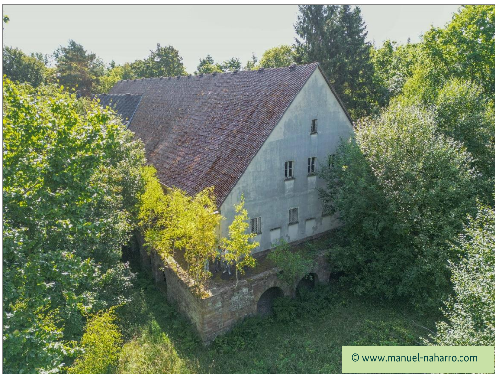
Abbildung 8: Verkaufsobjekt C, hier: Ansicht aus Norden
