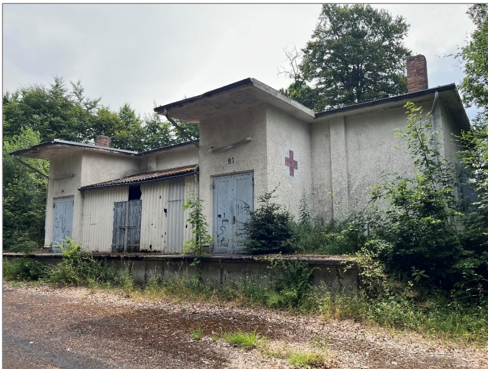
Abbildung 2: Verkaufsobjekt A, hier: Gebäude 91 aus Nordwesten
