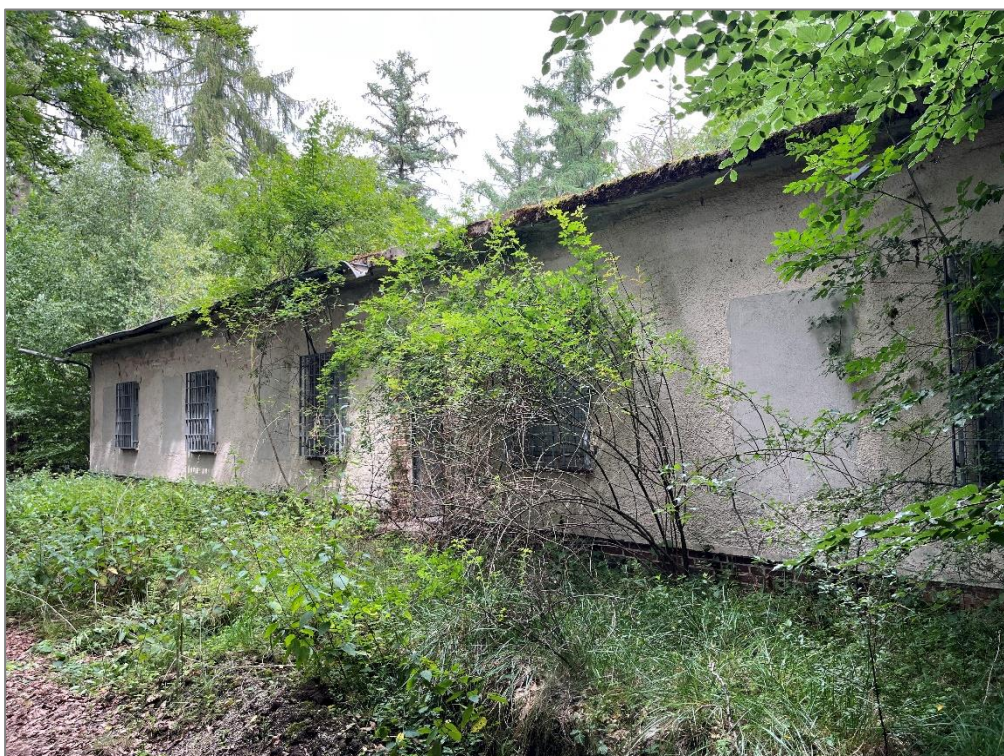
Abbildung 6: Verkaufsjekt B, hier: Ansicht Gebäude 71 aus Südwest
