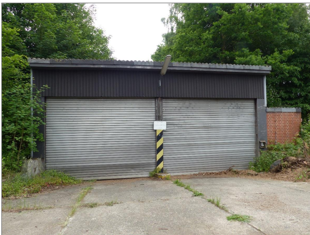
Abbildung 26: Verkaufsobjekt I, Gebäude 33 (Eingang ehemaliger Kleinkaliber-Schießstand)
