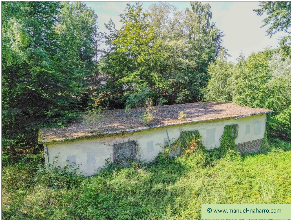
Abbildung 5: Verkaufsjekt B, hier: Ansicht Gebäude 71 aus Osten
