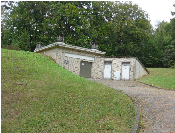
Blick Richtung Westen auf den zentralen Bereich des Plangebietes mit Wasserbehälter, Zufahrt und Vegetation
