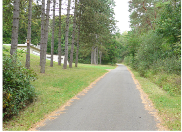
Erschließungsweg im südöstlichen Bereich des Plangebietes, links im Bild der Wasserbehälter (Blick Richtung Norden)
