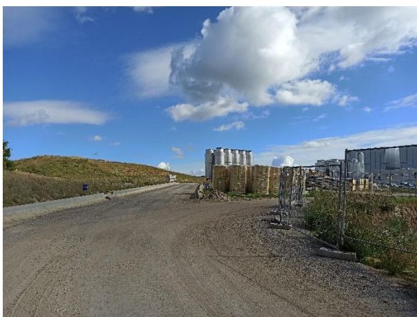
Abzweigung Wegführung mit Blick Richtung Norden
