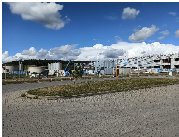
Zufahrt zu Parkflächen mit Blick Richtung Nord-Ost
