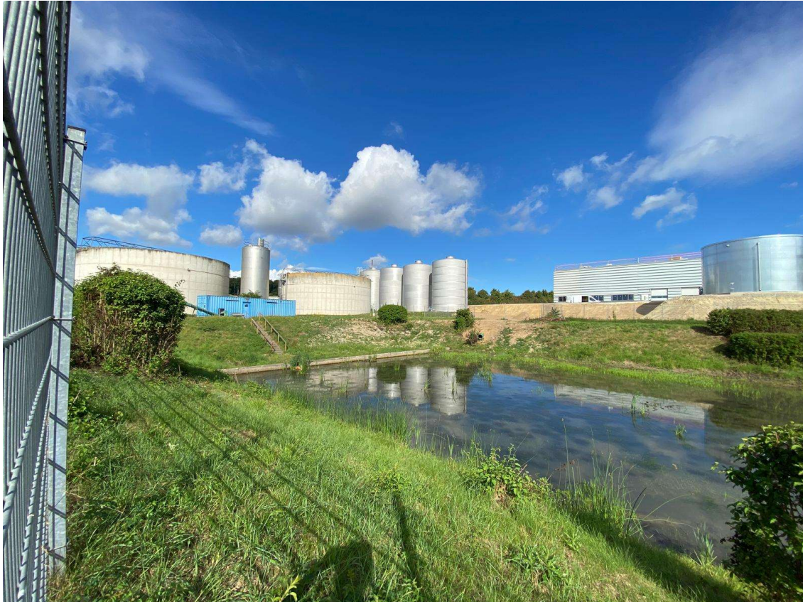
Abb. 3-2: Blick aus südlicher Richtung auf das eingezäunte Regenrückhaltebecken
