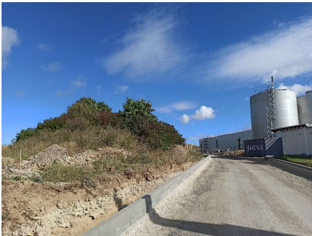
Abb. 3-4: Geschotterte Baustraße entlang des westlich gelegenen Gehölzstreifens
